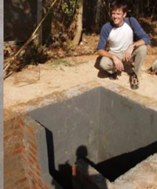
· Sceptic-tank; een compartiment is afgewerkt.
