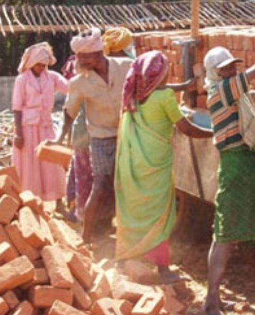
· Bouwvakkers halen bouwmaterialen van tractor
